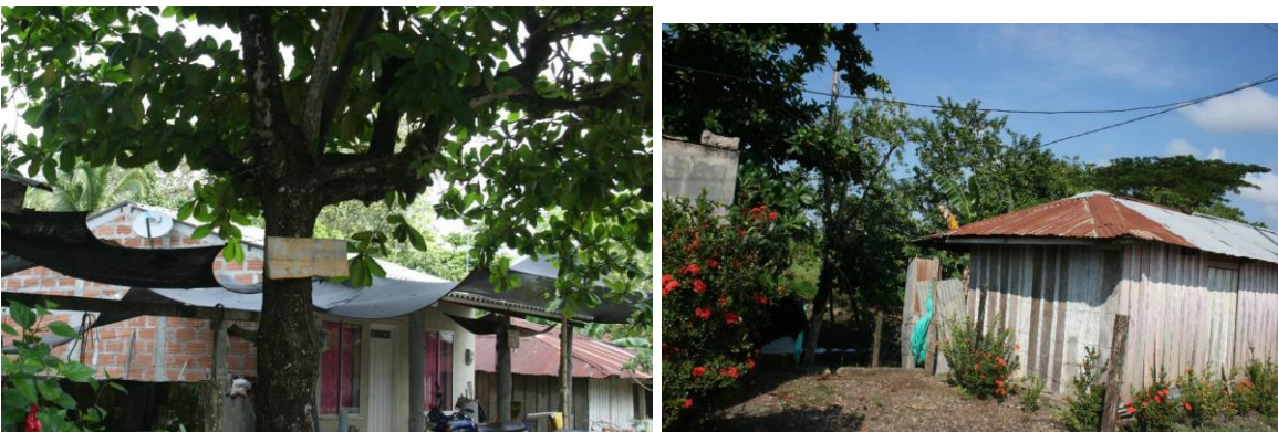
Imagen 8. Vivienda vía a Otanche
