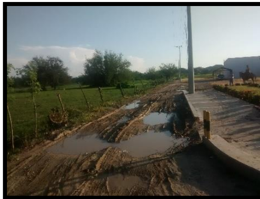
Foto 5. Calle 33, a la altura de la Cra. 5
